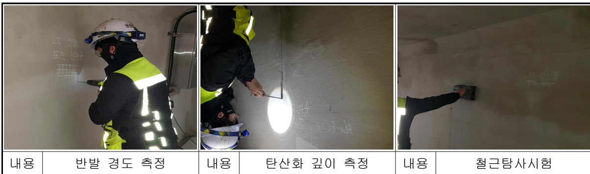
【사진 2.5】 포천인출 전력구 재료시험 전경
